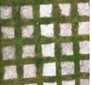
Surfaces semi-ouvertes          | Infiltration d'eau de pluie avec végétation (dalle en bois, copeaux de bois, treillis de pelouse, pavés engazonnés) |
