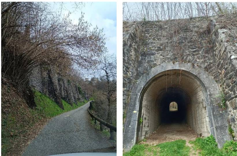
FIGURE 42 - Mur portant la voie ferrée et passage sous la voie ferrée
