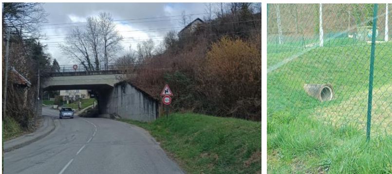
FIGURE 47 - Passage sous voie ferrée (gauche) et déversoir (droite)
