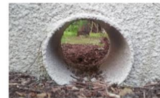
Aménagements d'ouvertures en pied de muret Clôtures perméables au déplacement de la petite faune
