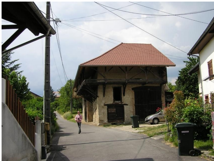
Grange en pisé et galets roulés et séchoir à noix sous toiture
