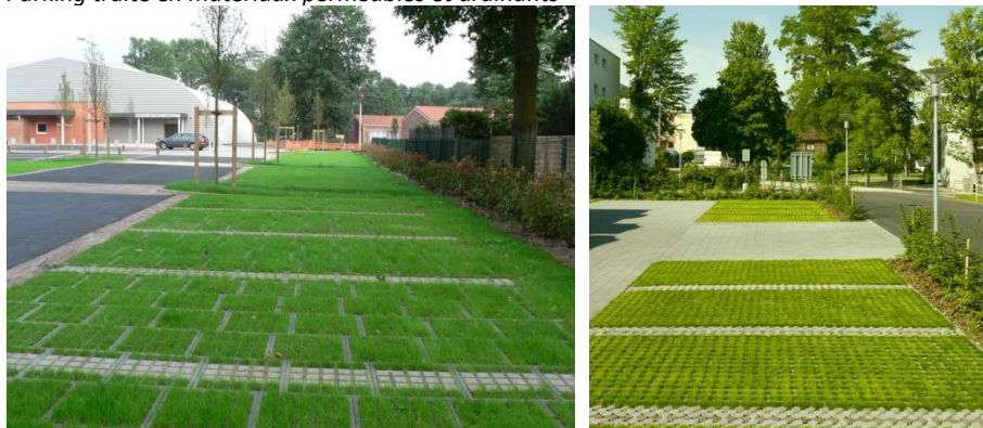
Parking traité en matériaux perméables et drainants
