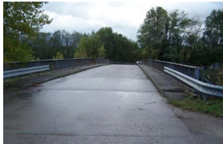
Pont de Treffonds au-dessus de l'A48 Photo M. Botton / Le Pic Vert.
