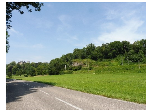
Vue du sentier joignant la halte ferroviaire au centre-bourg longeant le talus de la voie ferrée
