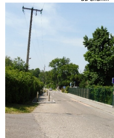
Vue de l'alternat et des trottoirs réalisés en amont de la mairie
