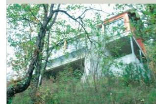
→ Sur ce terrain à pente «extrême» où le rocher est affleurant, la solution de se surélever du sol s'est imposée au concepteur. La maison développe ses niveaux en cascade, ce qui permet la réalisation d'une grande terrasse accessible qui compense la difficulté d'utilisation du terrain. Un espace «sanitaire» a été créé entre la maison et le rocher pour limiter les infiltrations des eaux de ruissellement.
